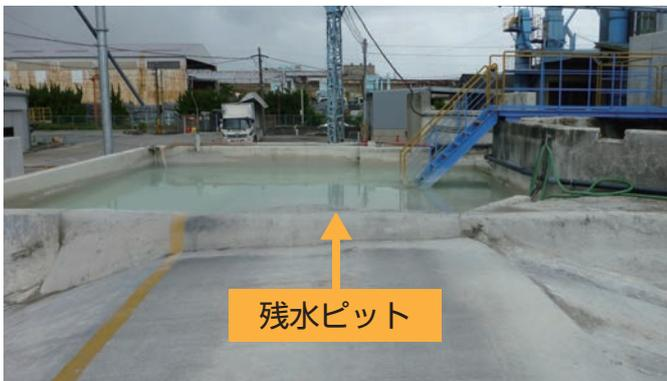
⑦ 洗い場は、敷地南西側（⑥ バッチャープラントのウラ）にあります。（3台洗浄可能）黄色いラインに沿って、タイヤ止めに後輪が当たるまでバックし停車して、残水処理・洗浄を行います。残水は、横の残水ピットに排出します。
